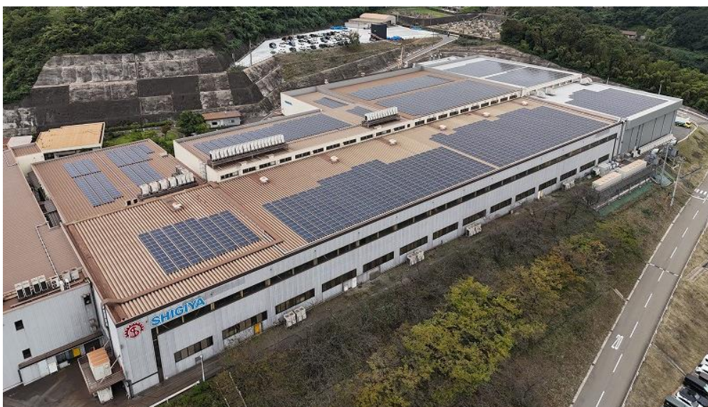
シギヤ精機製作所 本社工場
